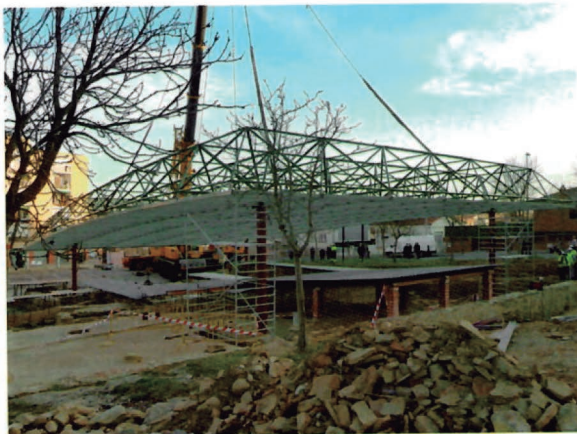
Figura 21.11. Instal·lació de la primera coberta protectora definitiva.
