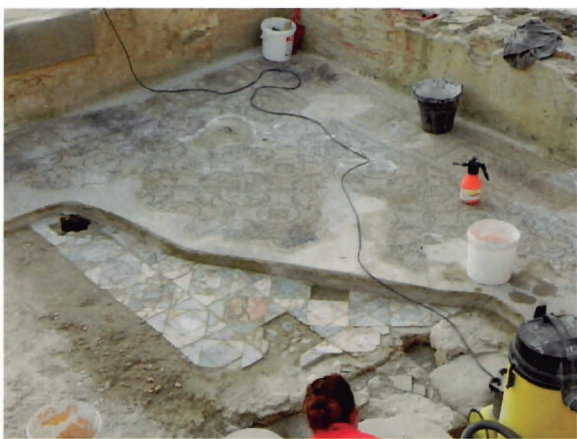
Figura 21.5. Primer pla de la consolidació del mosaic de l'àmbit A15.
