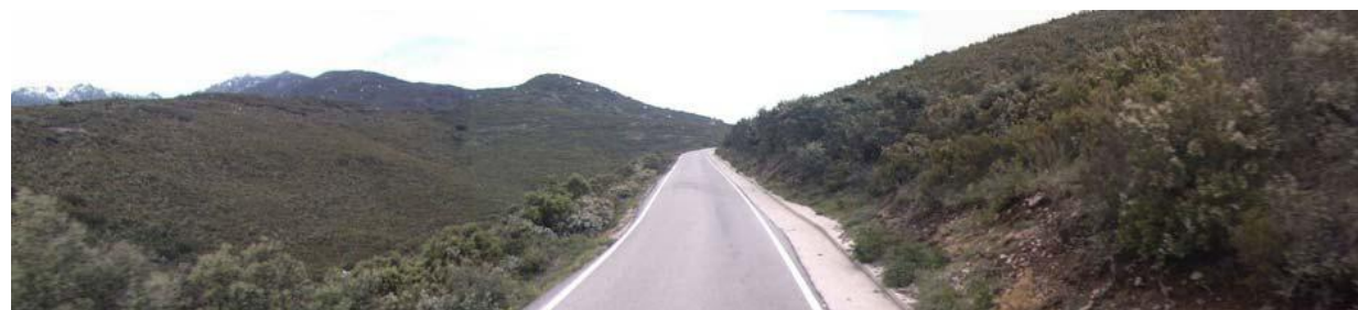
Camí actual en al PK 8+300 (dins la zona de protecció)
