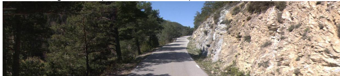
Camí actual en el PK 3+300 dins la zona de protecció
