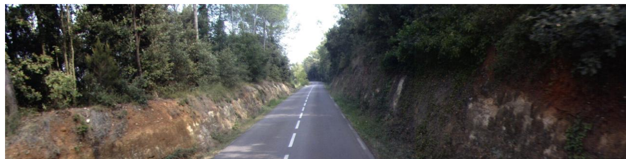
Carretera en el p.k. 8+800 on la zona de protecció comença en el marge dret de la carretera
