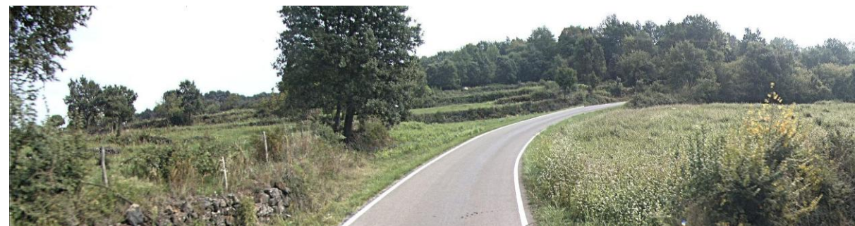
Carretera actual en el PK 2+800 dins del Parc Natural de la Zona Volcànica de la Garrotxa
