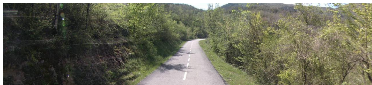
Camí actual en el PK 4+400 dins la zona de protecció
