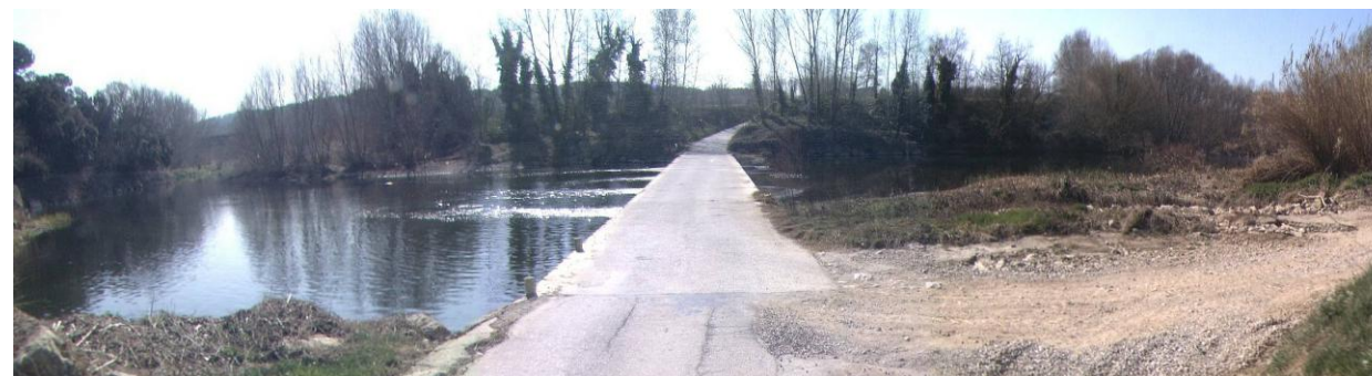
Camí actual en al PK 1+560 quan creua riu Ter (dins la zona de protecció)
