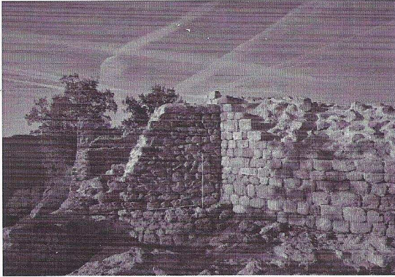
Figura 2. Seqüència constructiva dels elements perimetrals del nord: restes parcials d'un mur circular (UE 1201 a la part inferior esquerra) sobre el que es recolza la torre circular (UE 1007) amb el seu basament quadrat (dreta) i les seves posteriors reparacions (part superior esquerra).
