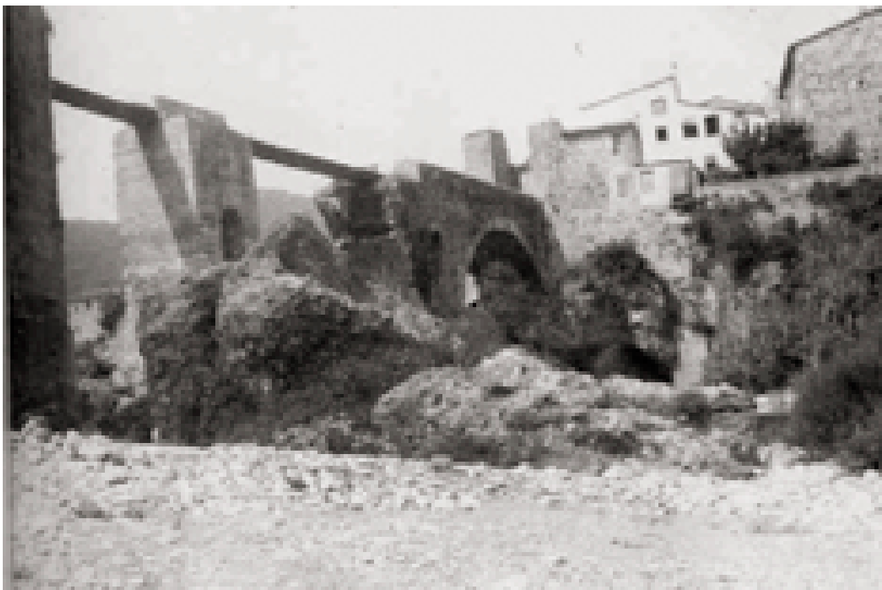
Vista parcial del primer sector del pont a principis dels anys seixanta, on es poden observar els estralls produïts per la voladura parcial del pont, efectuada per les tropes republicanes en retirada.
