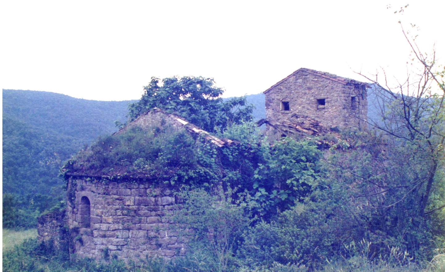
Vista general nord-est
