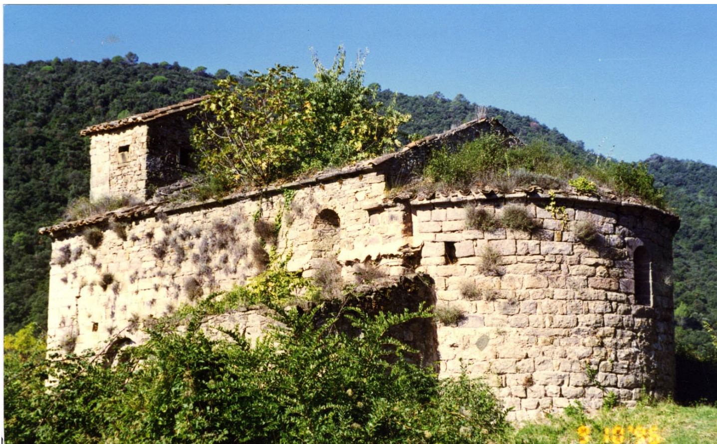
Vista general sud-est
