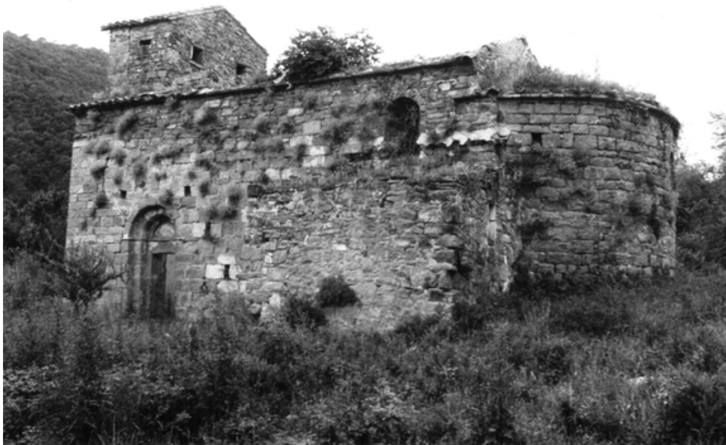
Vista general sud-est
