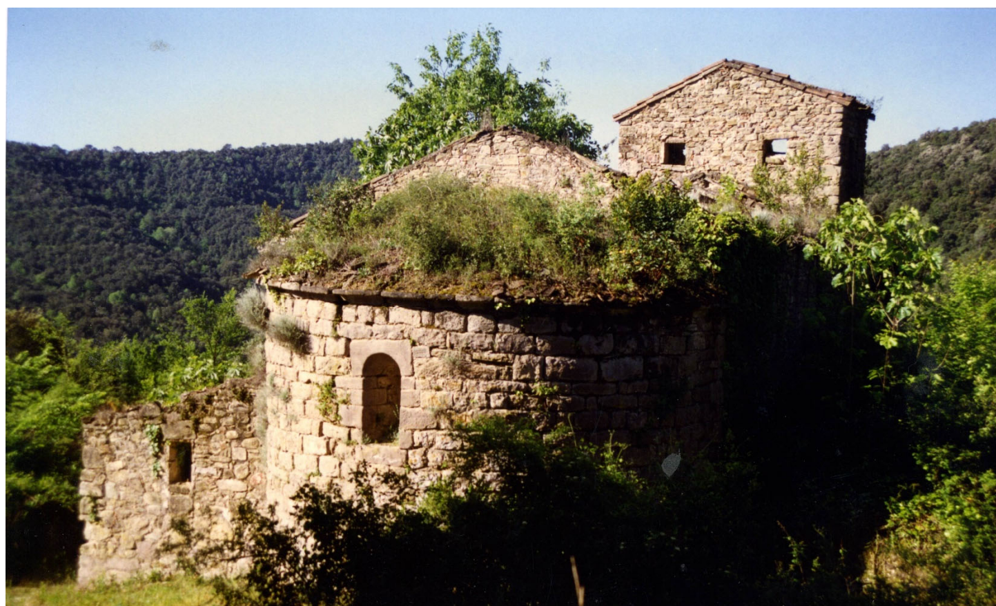
Vista general nord-est
