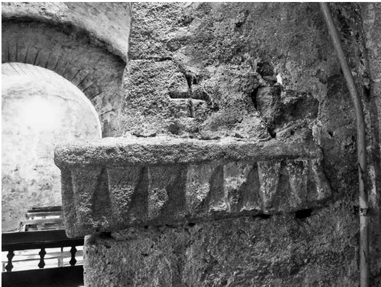
FIGURA 10: Primer pla d'una de les impostes decorades amb un fris en dents de serra, que sostenen l'arc triomfal. Font: Servei de Monuments.
