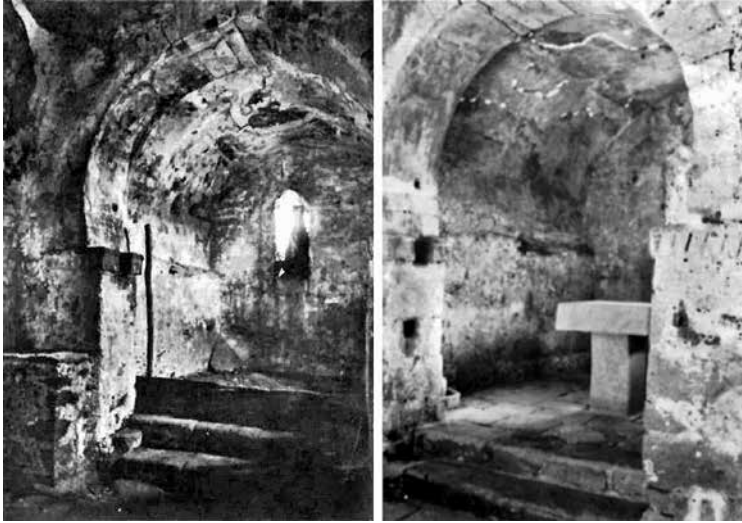
FIGURA 5: Altar de l'església entorn de 1918 i després de la restauració de l'any 1982. Font: fullet d'inauguració de l'obra, Servei de Monuments, 1982. Autor desconegut.
