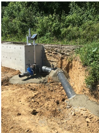
FIGURA 3. Arqueta al canal i elements per distribuir l'aigua a la parcel·la de reg per superfície automatitzat.
