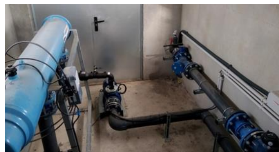
FIGURES 6 i 7. Models de capçals de reg per degoteig. El primer, provisional, durant la durada del cultiu; el segon, permanent, dins d'una caseta de reg.
