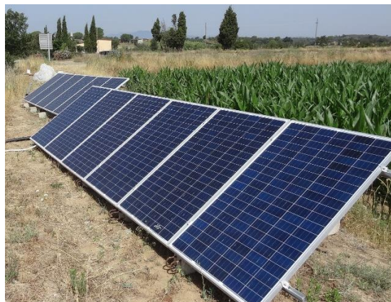
FIGURES 3 i 4. Dues instal·lacions de panells fotovoltaics per al reg solar.
